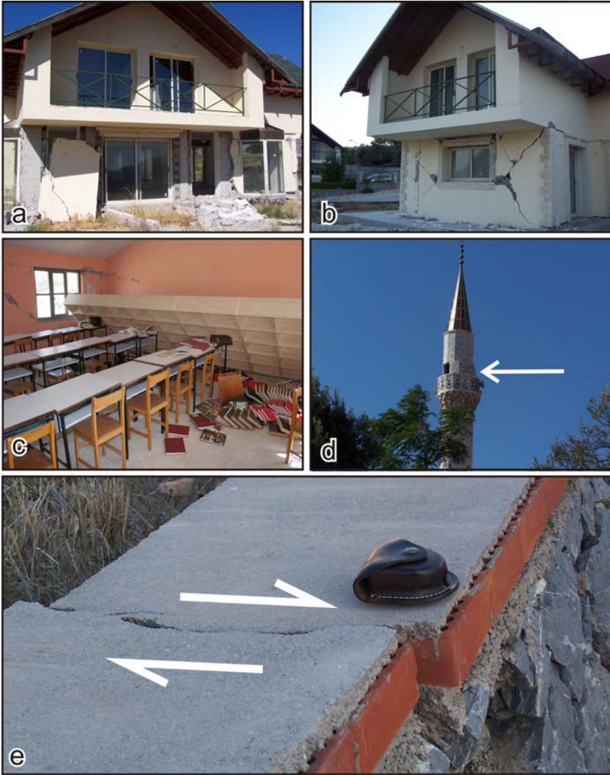
Şekil 6. Sığacık depremlerinin şiddet ölçüsünü belgeleyen hasarlar: a) ve b) villa tipi evlerde yıkılmış ve makaslanmış duvarlar, c) Sıraların üzerine devrilen Köy Kütüphanesi'nin rafları, d) Köyün minaresindeki düşey ekseninde kayma ve e) Bazı villaların bahçe duvarlarında gözlenen sağ yönlü ötelenmeler.
